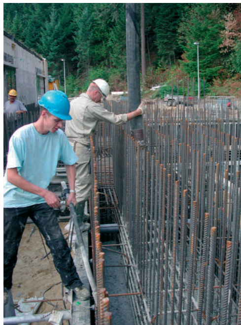
storten fundering stralingsbunker met mengsel 3
