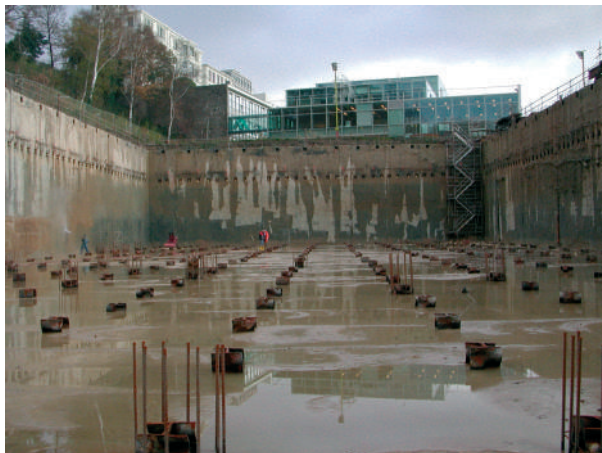
14 m diepe bouwkuip met onderwaterbeton en diepwanden
