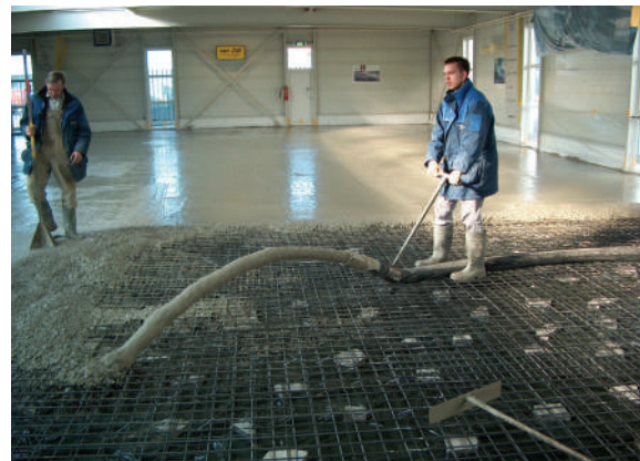
beton storten met een betonpomp
