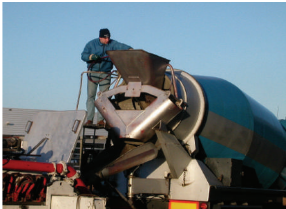
water toevoegen in het werk is NIET toegestaan!
