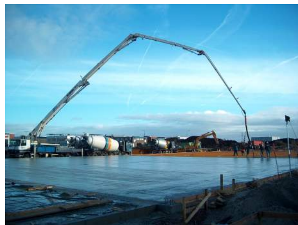
figuur 1: beton storten met een betonpomp
