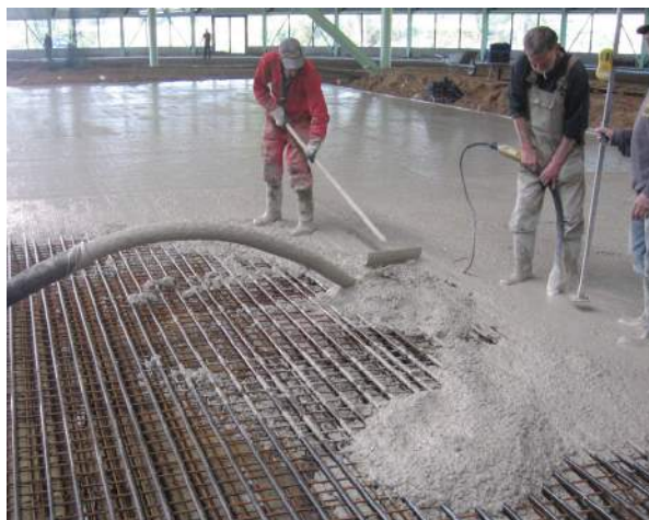
figuur 4: overzicht betonstort
