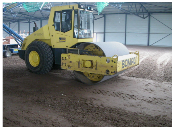
verdichten van de ondergrond met een zware trilwals
