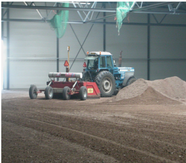
uitvlakken puinpakket met lasergestuurde apparatuur
