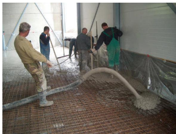
figuur 5: stortwerkzaamheden van een bedrijfsvloer
