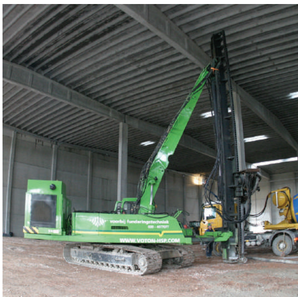
figuur 4: HSP-stelling tijdens uitvoering
