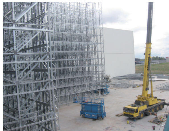
Siloconstructie Vriesveem fase 4 te Bergen op Zoom
