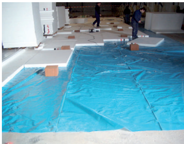
Uitvoering isolatiepakket met Azobé-blokken
