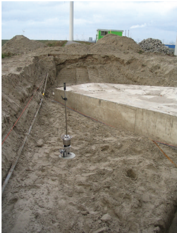
figuur 3: ondergrond controle ter plaatse van een windmolenfundament
