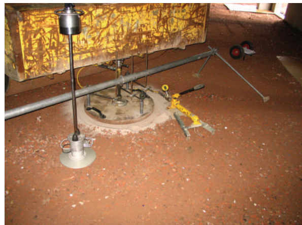
figuur 2: Prima 100 valgewichtdeflectatie met ernaast een opstelling voor een statische plaatbelastingsproef
