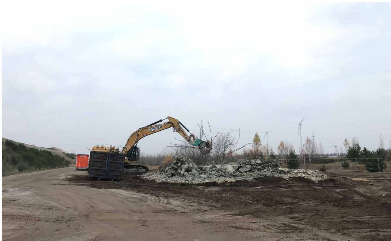
Sloop van een gewapende betonconstructie (ABT)
