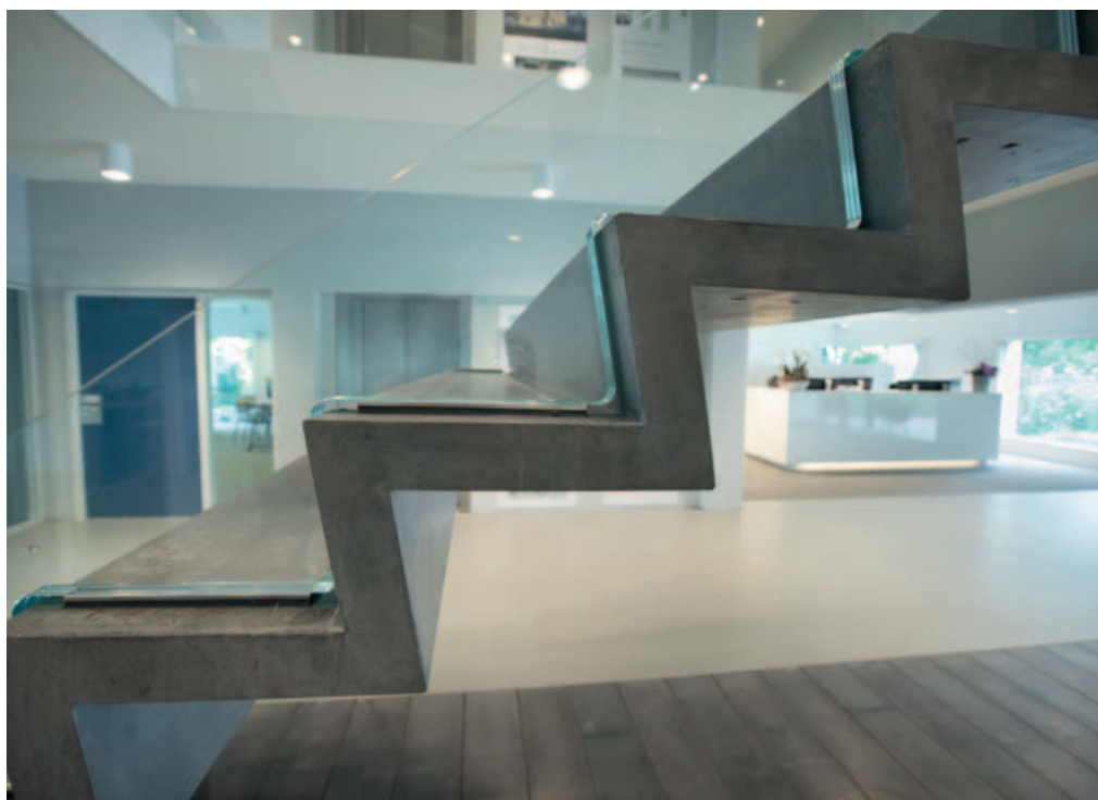
Met het glas verlijmden metalen strips zijn verborgen geschroefd op de betonnen treden.
