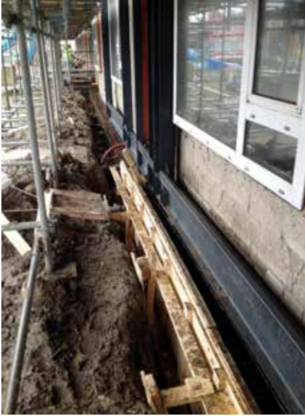
6. Blootleggen van bestaande fundering.
