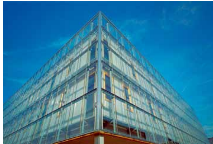
Het gebouw van ABT in Delft is een van de vroege voorbeelden van IFD-gebouwen. Het twintig jaar oude gebouw wordt nog steeds als voorbeeldproject gebruikt.
