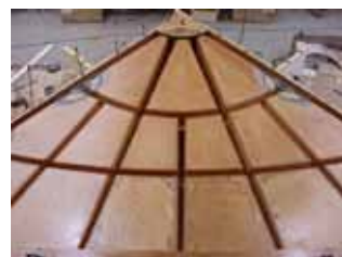
Textielbekisting, vacuumbekisting en houten bekisting van Folly Zonnestraat in Hilversum
