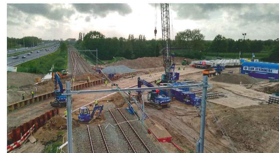
Overzicht van het inrijden van het spoordek van de autotunnel.
