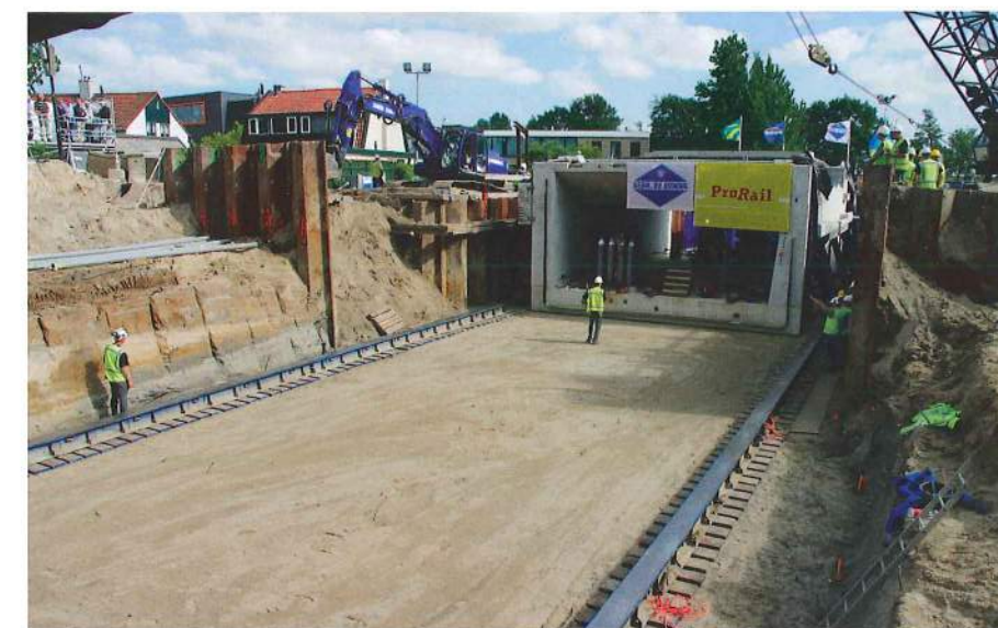
Het schuiven van de spoorwag voor de onderdoorgang voor fietsers en voetgangers.
