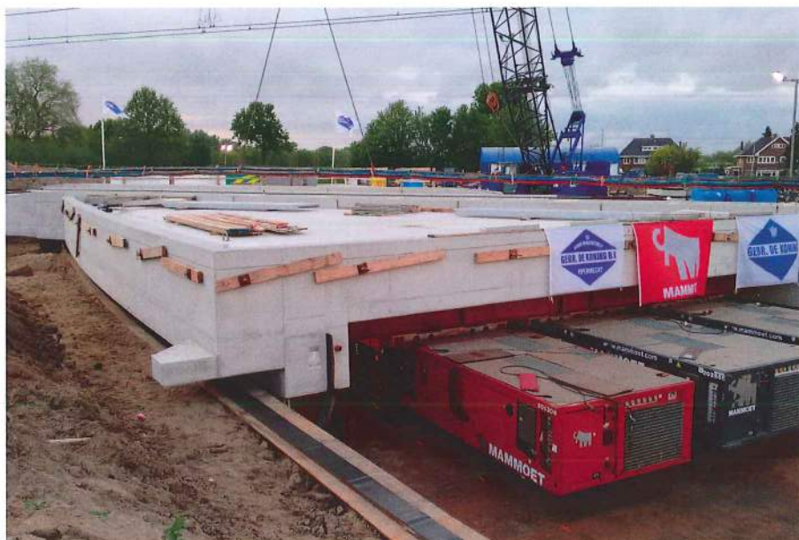
Het inrijden van het spoordek voor de snelverkeersonderdoorgang.
