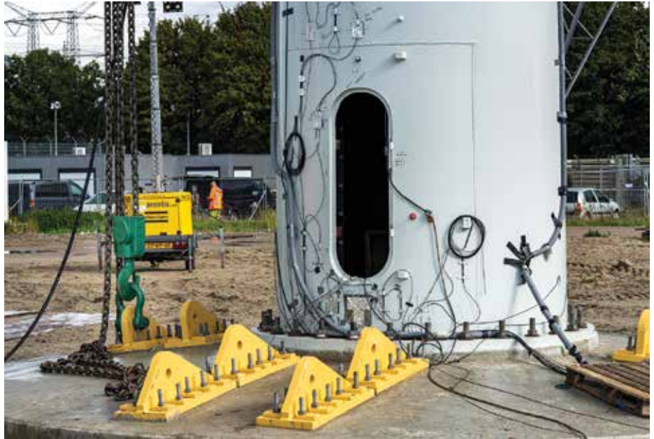
4. Meetsensoren deuropening. De gele ankerpunten zijn gebruikt voor de lieren bij de test van de hoekmast.
